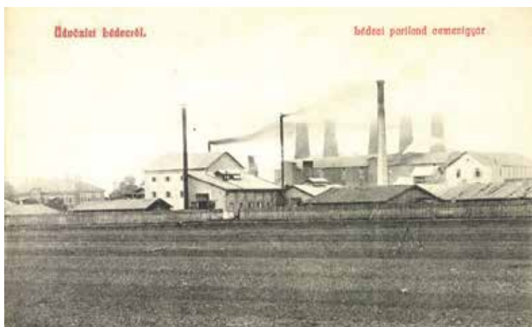
Pohľad na severozápad a cementáreň pri Ladcoch na konci 1. sv. vojny.
