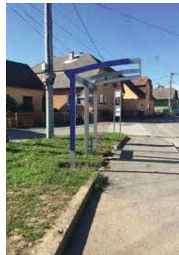
Zastávka MHD Horné Kočkovce.
