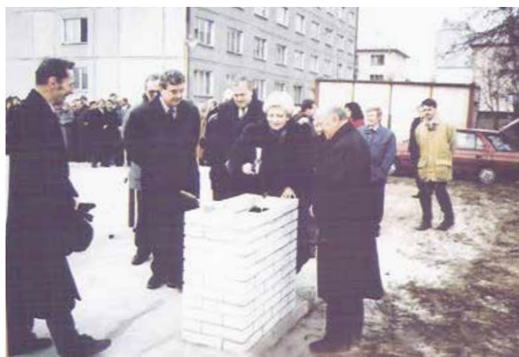
Začiatok II. etapy výstavby „Vzdelávacieho areálu Kolonka“ 21. 11. 1997 sa začala realizovať výstavba budovy laboratórií FPT v Púchove s rozpočtovým nákladom 70 mil. slovenských korún.
