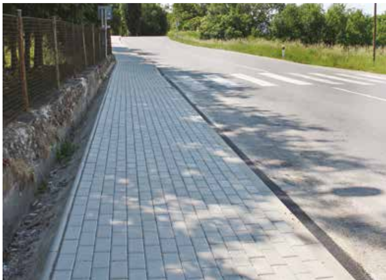
Chodník na Kolonke po dokončení v máji 2018.
