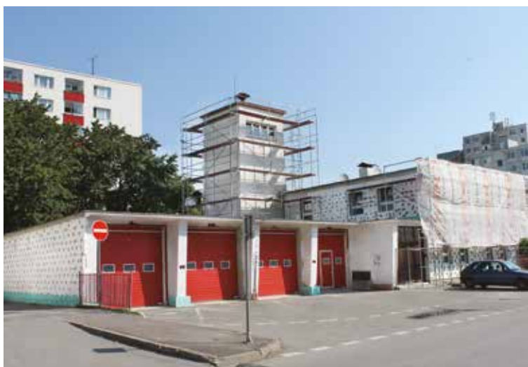
Začiatok rekonštrukcie hasičskej zbrojnice v júni 2018 (na titulnej strane fotografia z júla 2018).
