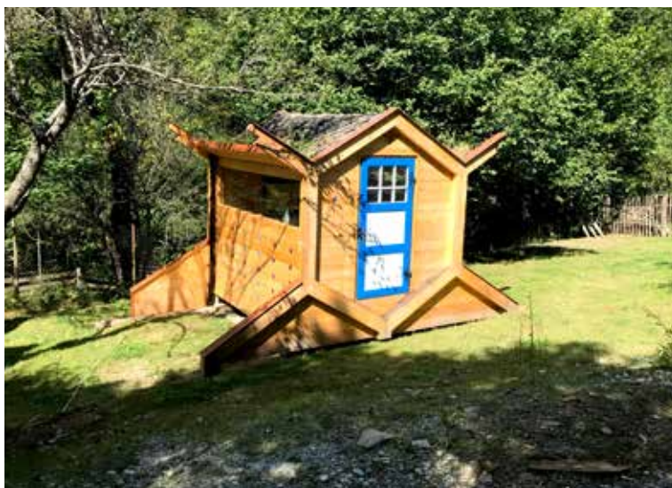
Apidomček je atypický včelín v tvare včelej bunky, ktorý je upravený na bezpečný pobyt ľudí v ňom. Je postavený z dreva, ošetrený špeciálnymi prírodnými farbami a primárne konštruovaný pre potreby ozdravných pobytov.
