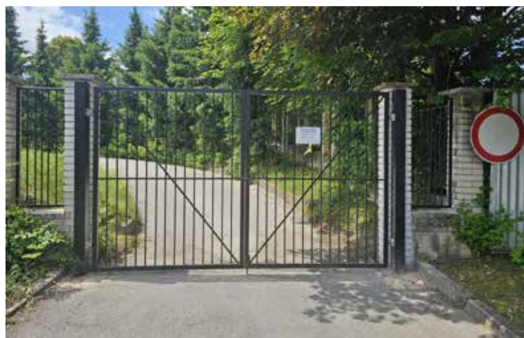
Aktuálny stav po rekonštrukcii
