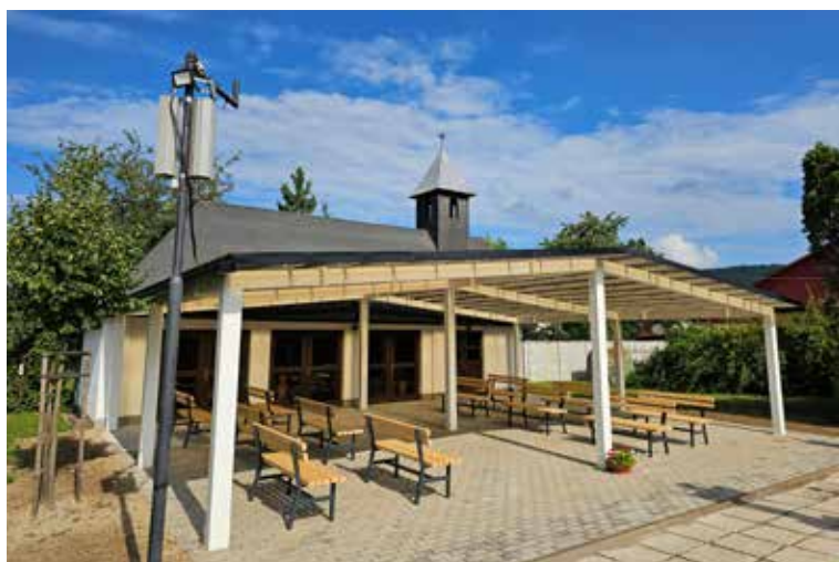
Prístrešok po rekonštrukcii
