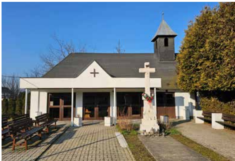
Pôvodný prístrešok pred rekonštrukciou
