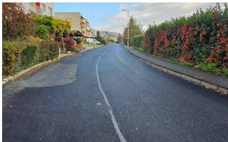
Opravy ciest - križovatka Okružná, ulica Zábreh, lokálne opravy na Mojmirovej ulici, v železničnom podjazde do Horných Kočkovíc a na Vieske-Bezdedov
