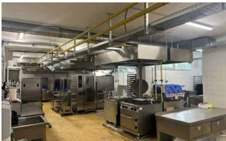
Výmena elektroinštalácie v kuchyni na ZŠ Mládežnícka
