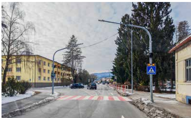
Bezpečnostné osvetlenie 2 priechodov pre chodcov na ul. Komenského
